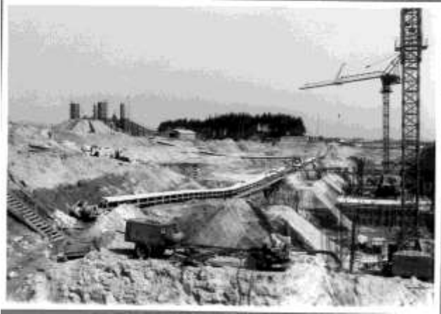
Gesamtansicht mit Betonförderband
